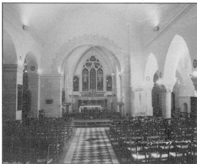
Fig. 2 – Savigny-sur-Orge, nef de l'église après travaux
