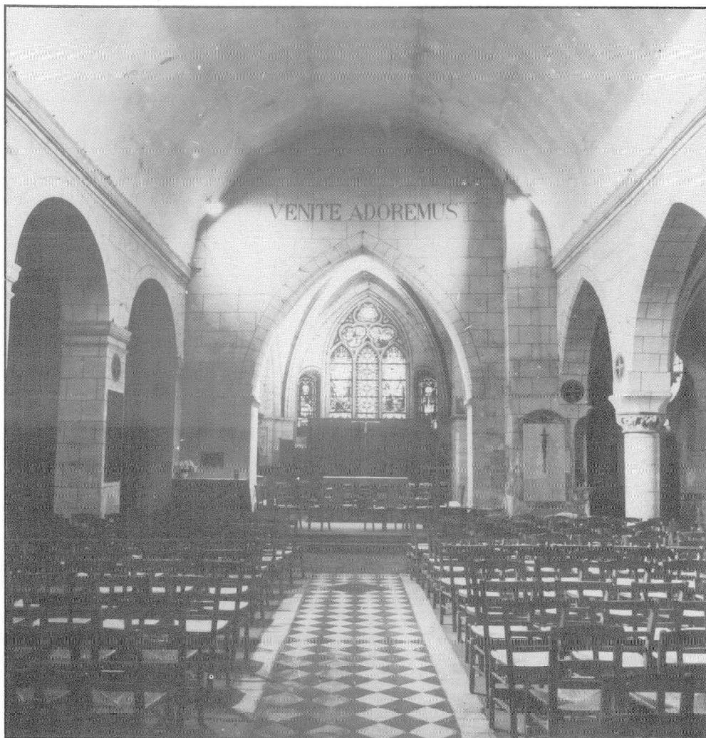
Fig. 1 – Savigny-sur-Orge, nef de l'église avant travaux
